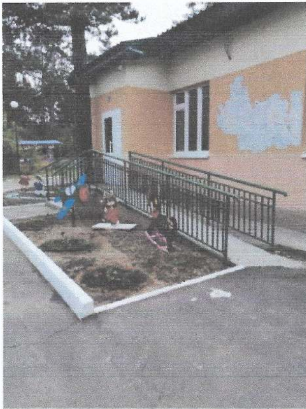
Фото 1. Территория, прилегающая к зданию (участок)
